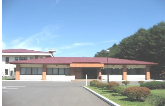
滝沢処理センター
