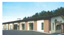
↑第2処理棟(H17~)
