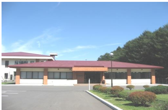
滝沢処理センター
