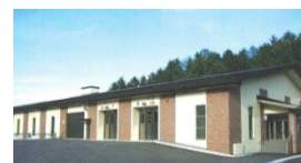
↑第2処理棟(H17~)
